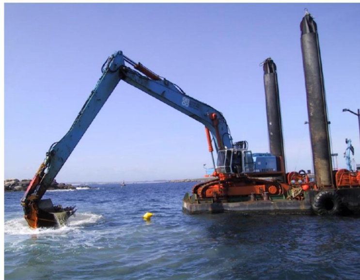
Figure 14 : Pelle mécanique sur ponton flottant
